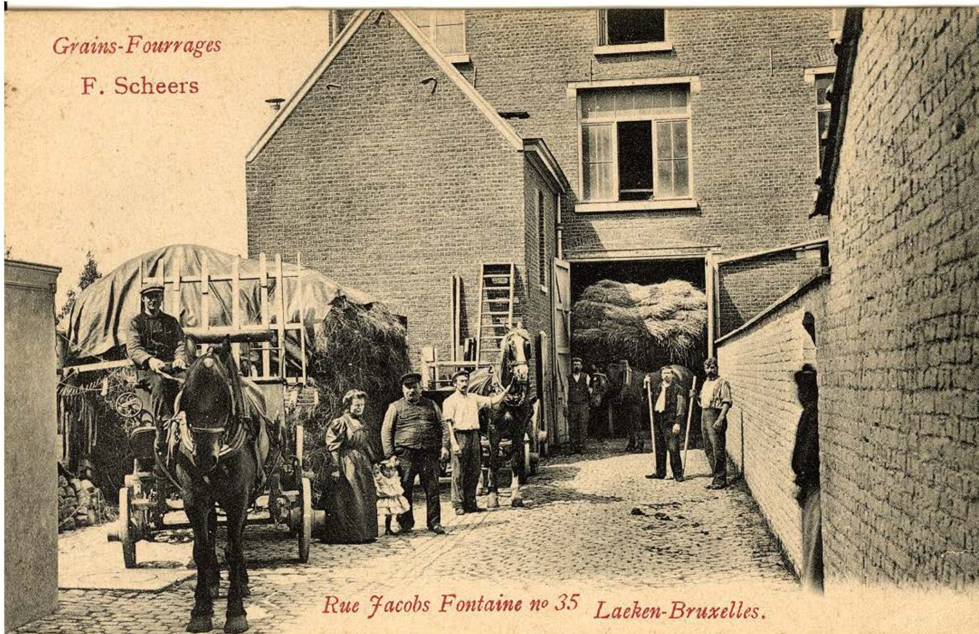
De binnenkoer van het pand gelegen in de Jacobs Fontainestraat, nr. 35. Het achtergebouw brandde enige jaren geleden volledig uit, maar werd door de eigenaar, een schrijnwerker, volledig gerestaureerd. Foto: omstreeks 1910.
